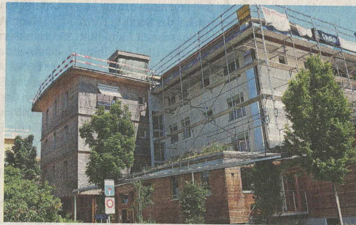
Die Umbauarbeiten gehen zügig voran.
